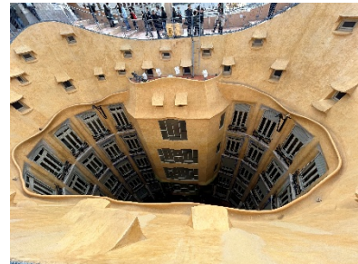
図 24 屋上から見たカサ・ミラの内部
