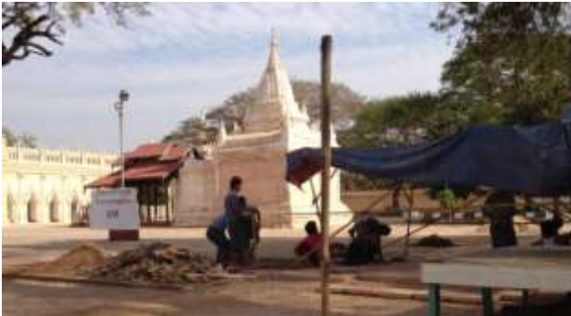
床の張り替え作業中
