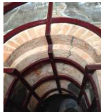
鉄骨で固められた天井
