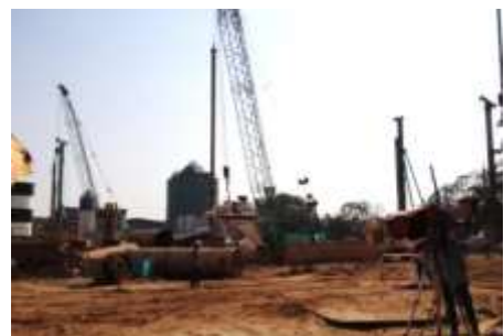
日本のビル建設中の現場
