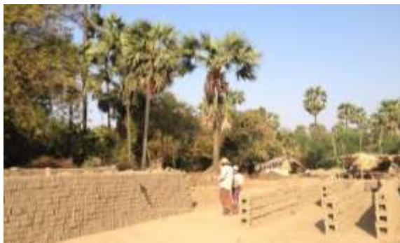
新しい仏塔を建設中↑→
