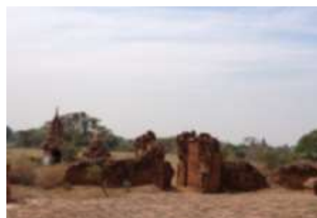
崩れてしまった門
