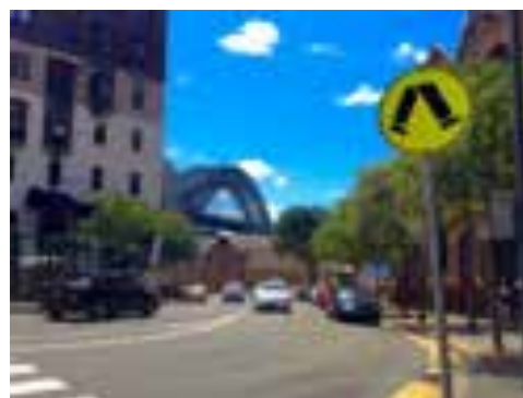
図2 歴史ある建物とハーバーブリッジが融合した様子
