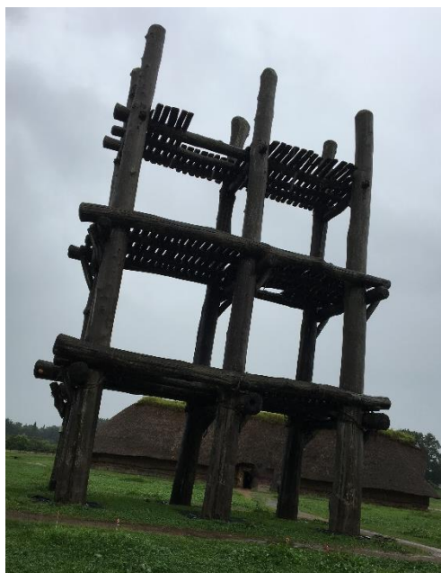
図18 大型掘立柱建物（本人撮影）
